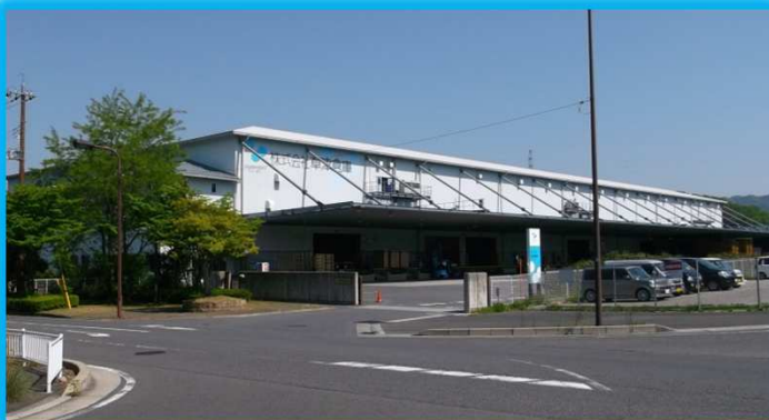
全長135mのプラットフォーム、広い荷捌場を設置！
